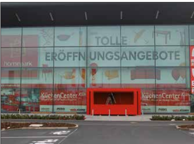
Kederschienen-System an Glasfassade
